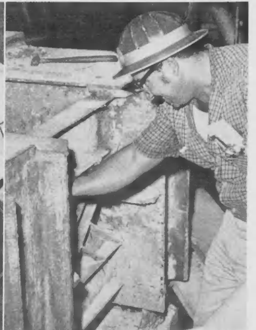
RIGGERNAN TA usa un chain block pa move un pida staal di tres ton for di e fundeshi di Combination Unit No. 5, robes. Un buraco ta worde cortá, centro, pa yuda den ponemento di e chain block. Nasario Tromp, Foreman di Metal Trades, drechi, ta inspecta e progreso.
